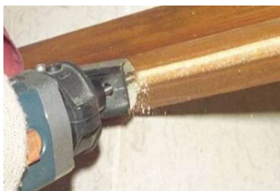
rögzítő nút készítése
